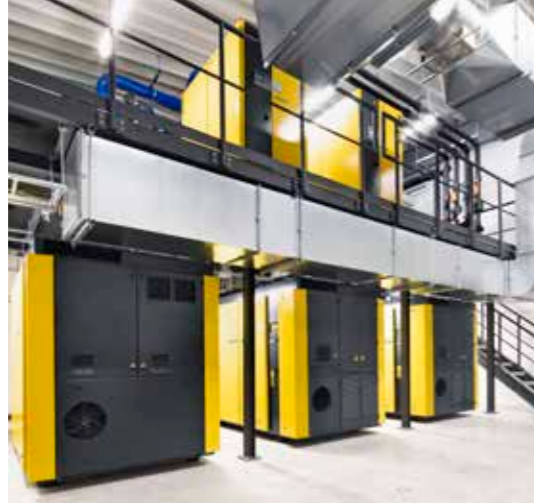
Bilde, venstre: Store flak av folie blir produsert inne i disse ruvende ekstruderne. Bilde, høyre: Den nye trykkluftstasjonen er plassert på to nivåer for å spare plass.
