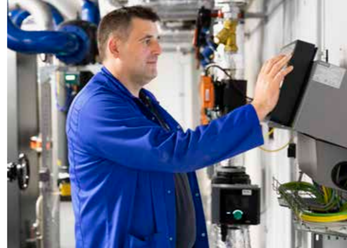
Der SIGMA AIR MANAGER 4.0 sorgt mittels bedarfsgerechtem Druckluftmanagement für bestmögliche Auslastung der einzelnen Kompressoren und effizientester Betriebsweise der Gesamtstation.
